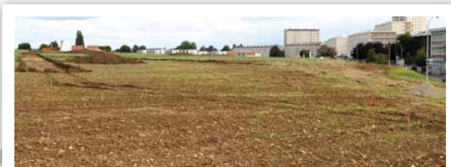
Première section des travaux de la "coulée verte"
