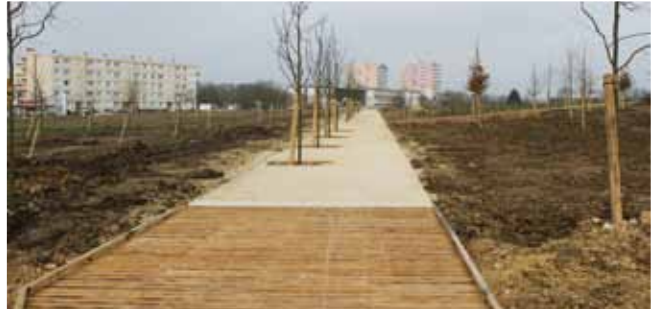
15 mars Les travaux de la Coulée verte avancent.
