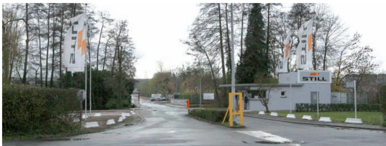
Les locaux de l'ancienne usine Still
